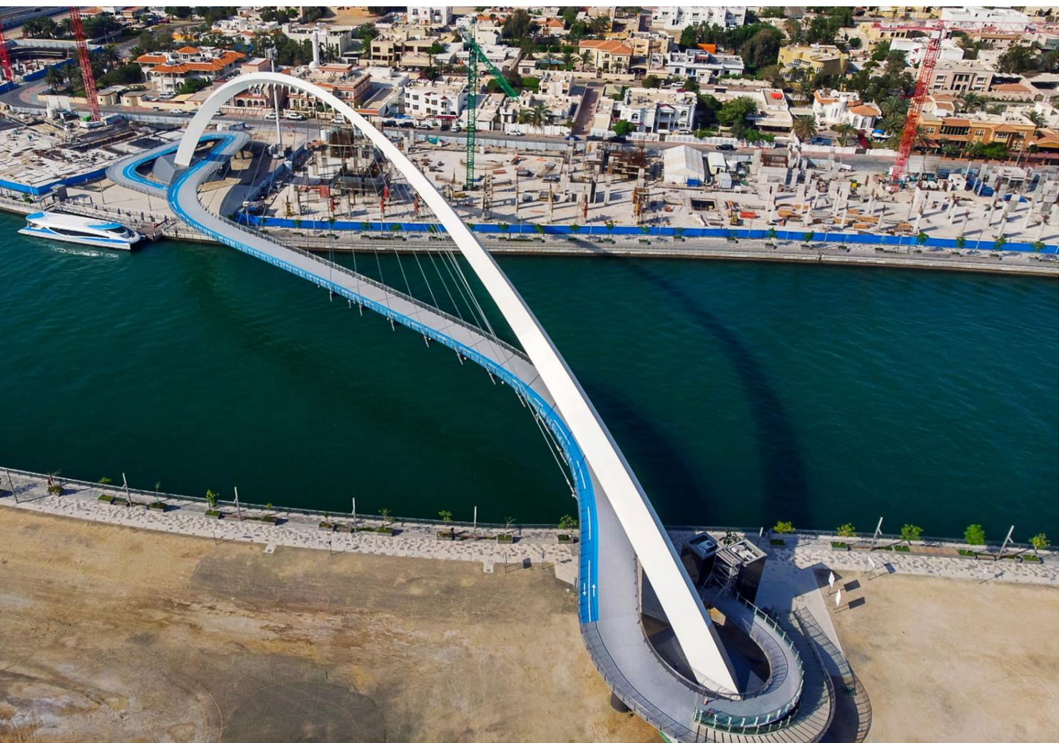
conci che sono stati poi sollevati in posizione con l'utilizzo di due gru cingolate da 600 tonnellate ed appoggiati su torri temporanee, installate nell'alveo del canale, che raggiungevano nel loro punto più alto i 53 metri di altezza. Il solo arco raggiunge un peso di 1.700 tonnellate e supporta il peso dell'intera struttura attraverso 20 cavi in acciaio (per una lunghezza complessiva di 858 metri) che supportano
